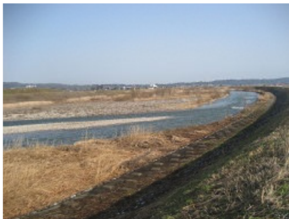
中流（余川橋－高田橋付近右岸側より）
