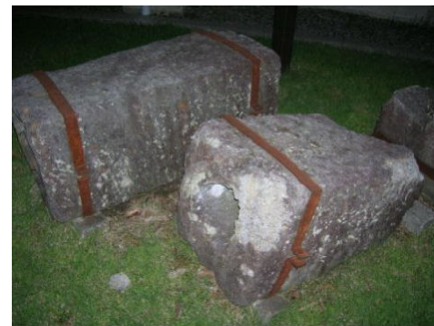
十二貫野用水導水管
