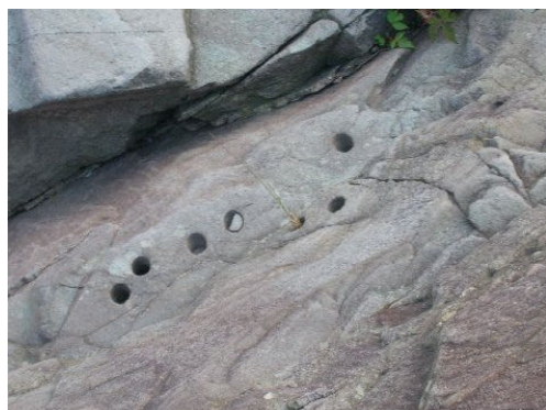
鎧壁基部の石切跡
