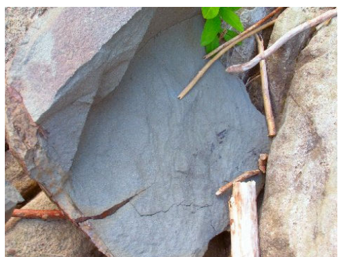
崩落した凝灰岩
