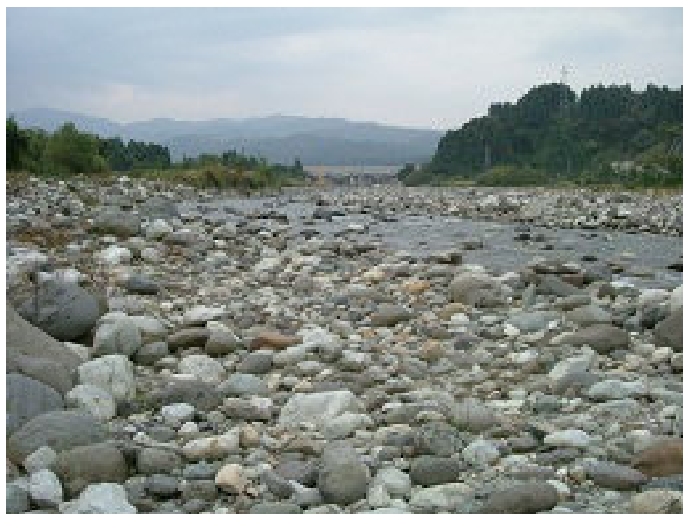
右岸側から上流方向のながめ
