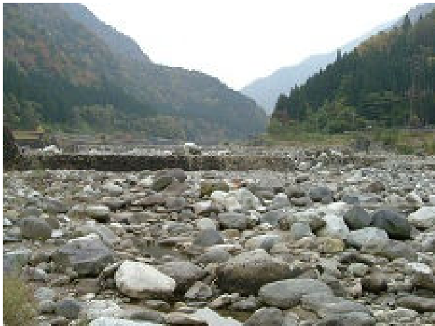
右岸側から上流方向のながめ
