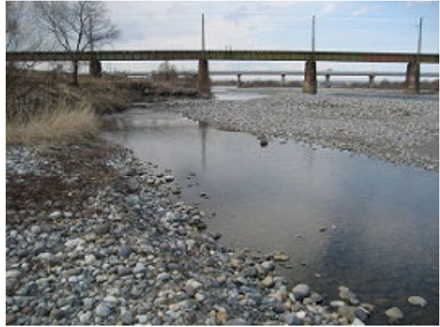
川原のようす（下流側近景）
