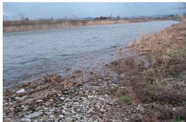
左岸から上流側のながめ
